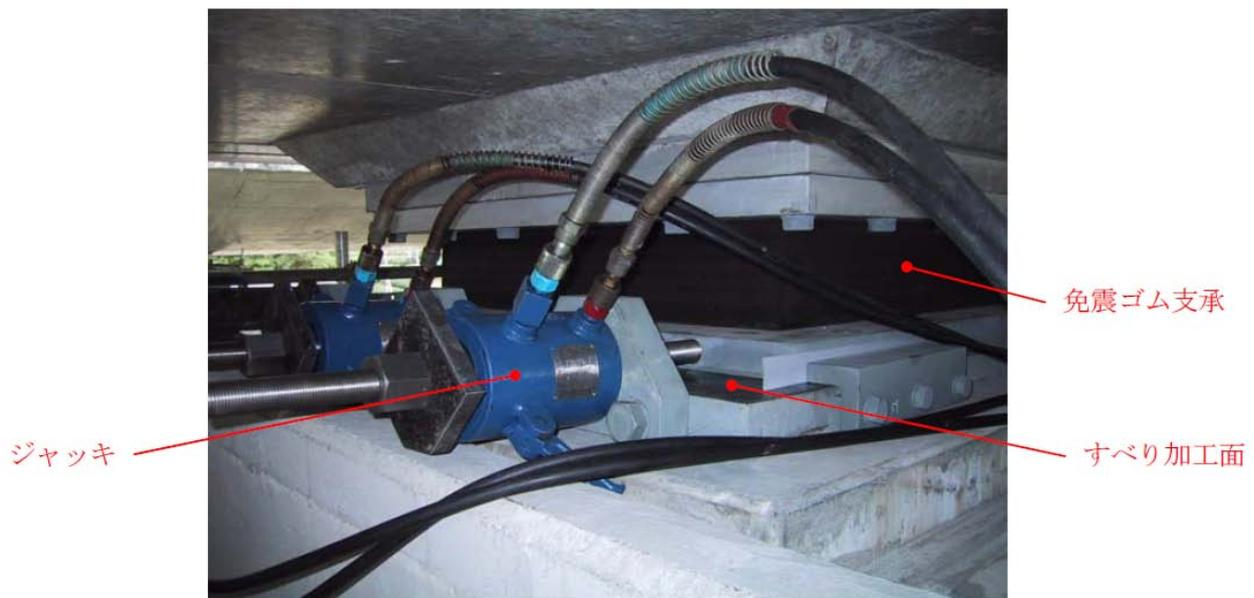
図-3 ポストスライド方式による免震ゴム支承の変形調整状況
